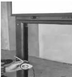
Schrauben zum Befestigen der Führungsschienen parallel zum Rahmen befestigen (im Schnitt jede 50 cm, jedoch nicht mehr als 3 Stück pro Seite). Die obere Schraube im Abstand von min. 4-5 cm von der oberen Fensterzarge anbringen.
