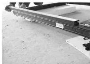
4. Den Kasten an den Fensterrahmen mittels Schrauben befestigen die Löcher befinden sich an den Seitenwänden des Kastens.
