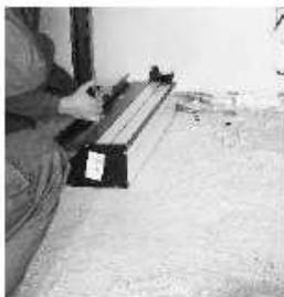
Den Aufsatzkasten auf den Adapter, beginnend von der Rauminnenseite, in dem das Fenster angebracht wird aufschieben. Der Kasten sollte im Adapter einrasten.
